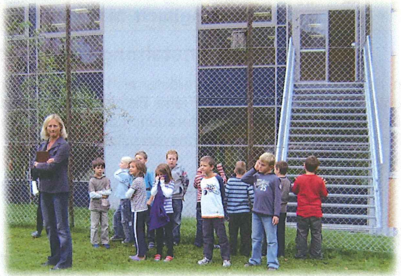
Foto Gemeinde Gaming: die Evakuierung über den neuen Fluchtweg der sanierten VS Gaming funktionierte sehr gut. Damit es jedoch im Ernstfall zu keinen Verzögerungen kommt wird der Zaun zum Sportplatz in Fluchtrichtung geöffnet.
