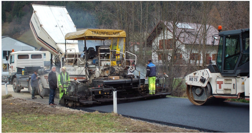
Foto Gemeinde Gaming: Bgm. Kurt Pöchlhacker bei den Asphaltierungsarbeiten in der Schleierfallstraße
